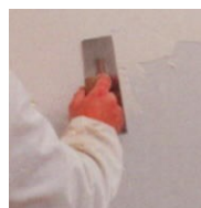
1. kerroksen levitys stuccolastalla
