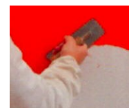
1. kerroksen levitys stuccolastalla
