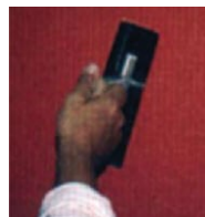
2. kerroksen tasoitus stuccolastalla
